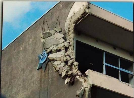
津波で流されてきた冷凍工場が、南校舎4階のベランダに激突しました。壁面は破損し、激突した方向に折れ曲がっています。
